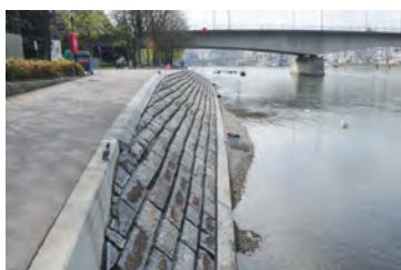
Neu gestalteter harter Uferbau am rechten Ufer
